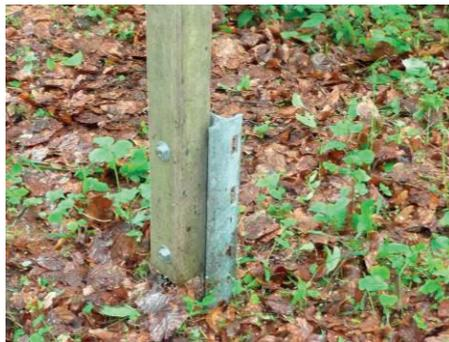
Bild 4: Mit eingerammtem Stahlprofil verschraubter Pfahl
